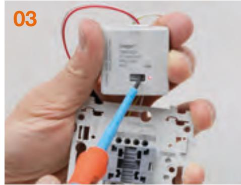
02 Selecionar a função (cor do LED) no receptor por breves pressões sucessivas no botão **fct**. Validar a escolha pressionando >2 seg. até o LED piscar.
